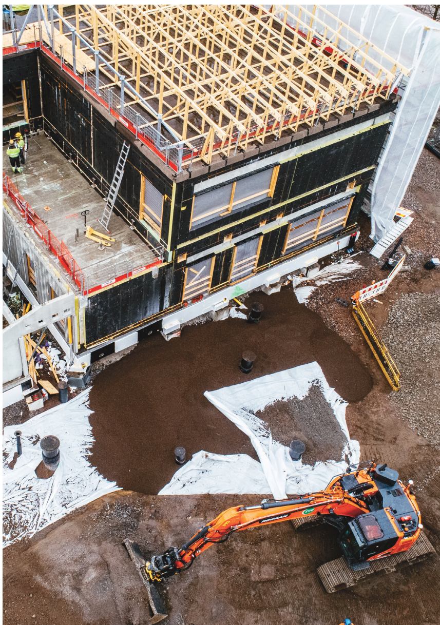
Para los rellenos ligeros de la escuela Puotila se utilizaron más de 2.000 m 3 de Leca LWA.
