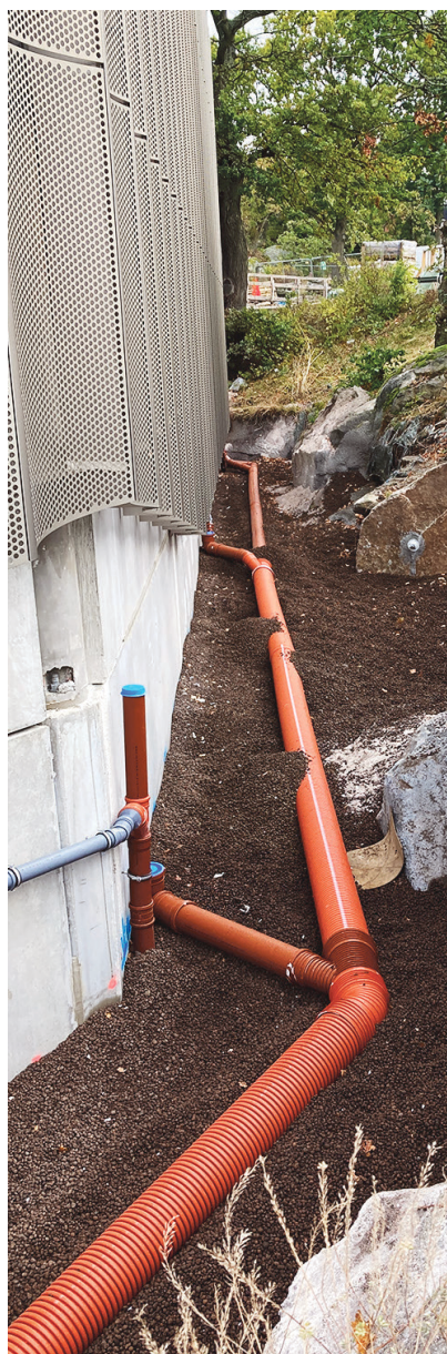
Leca LWA se utiliza como relleno para estabilizar la roca porosa junto al edificio.
