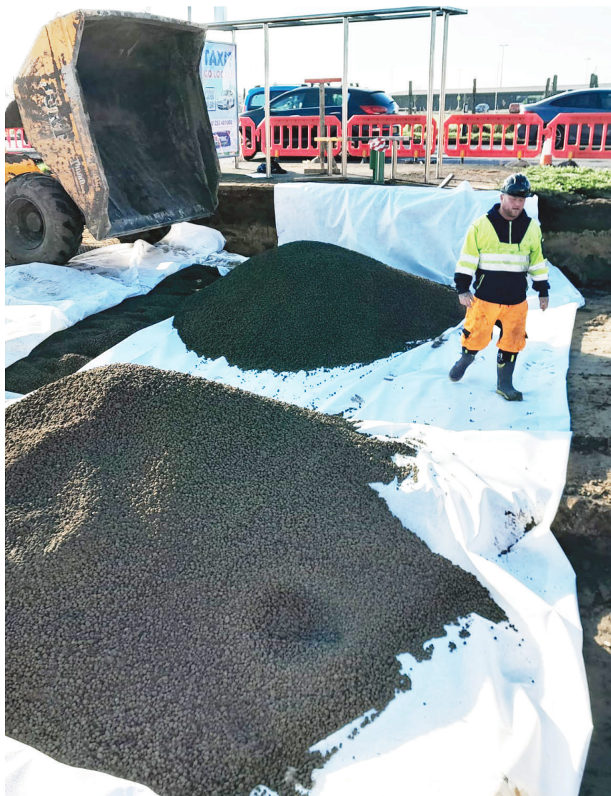
Como material de relleno ligero se eligió Leca LWA, que reduce considerablemente los asentamientos inducidos por las cargas.
