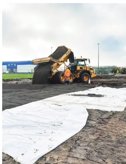
La presencia de terreno blando hizo que los métodos de construcción convencionales no fueran adecuados
