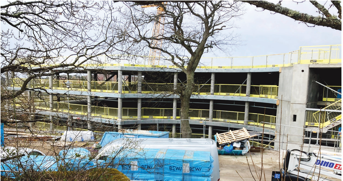
La estructura del parking fue adaptada para preservar el roble y proteger la biodiversidad local.
