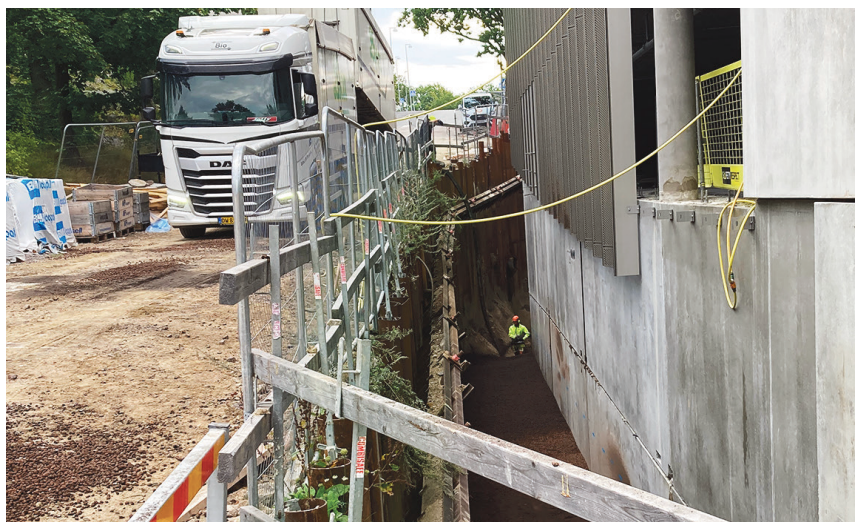
El LWA se suministra mediante bombeo para llegar a las zanjas de difícil acceso del aparcamiento.
