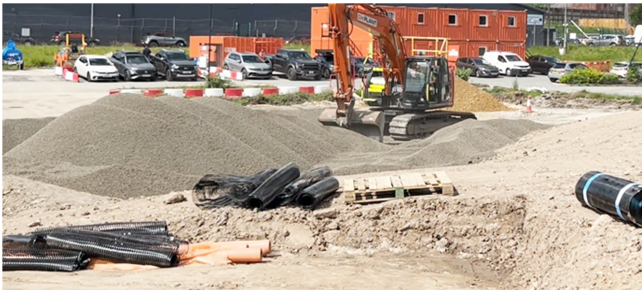
3 000 m 3 de Leca LWA utilizados en muros de contención para una nueva pasarela peatonal elevada.
