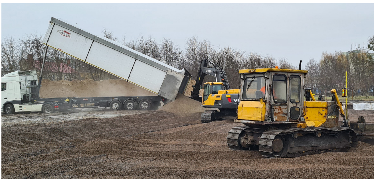
El Leca LWA fue suministrado mediante camión volquete, lo que permitió una instalación rápida y eficiente directamente en obra.
