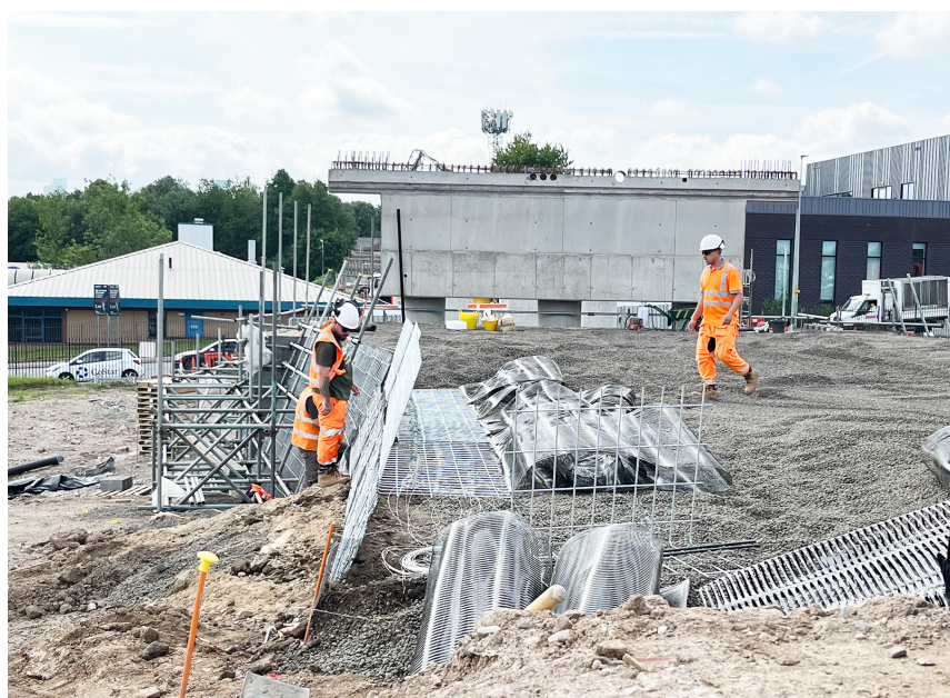
Relleno ligero requerido para reducir el riesgo de asentamientos y la carga estructural sobre los estribos del puente.
