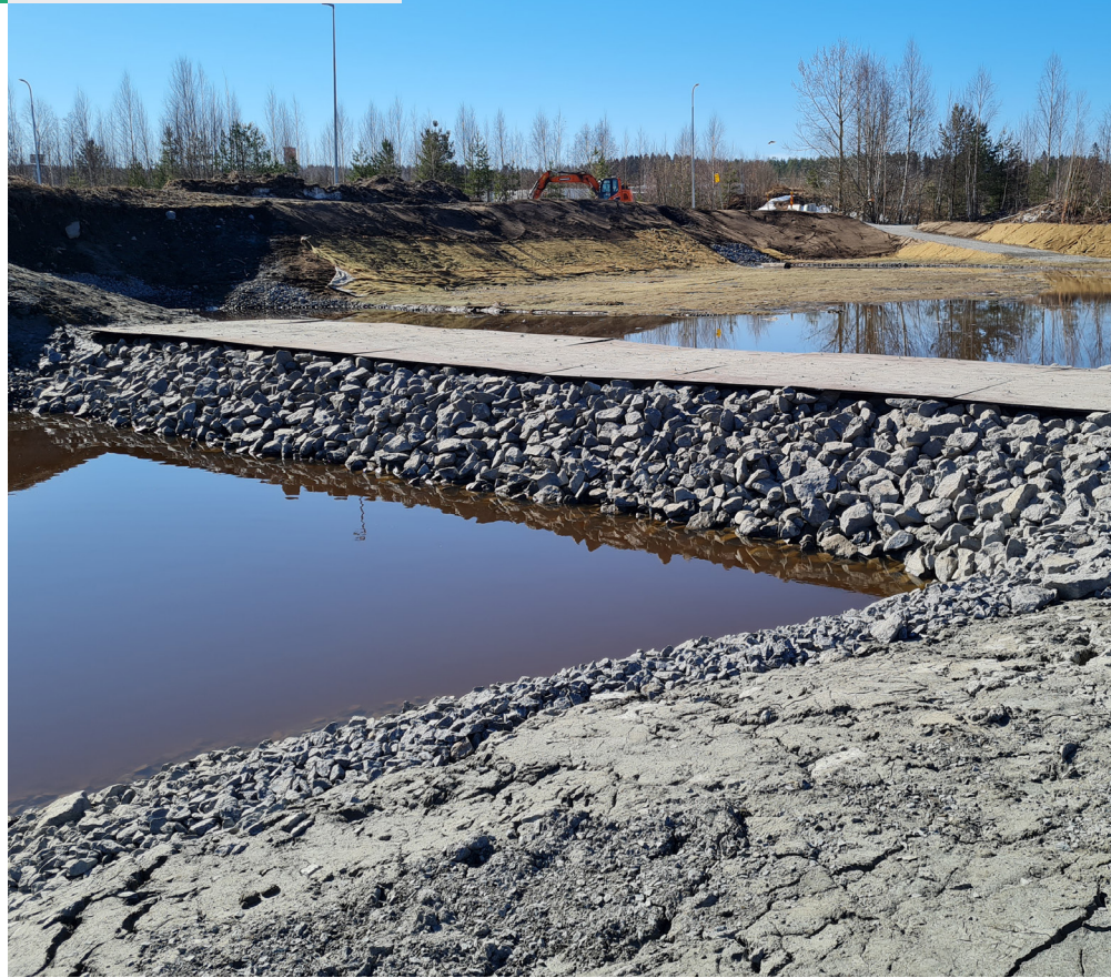
La presa terminada filtra el agua antes de su descarga.
