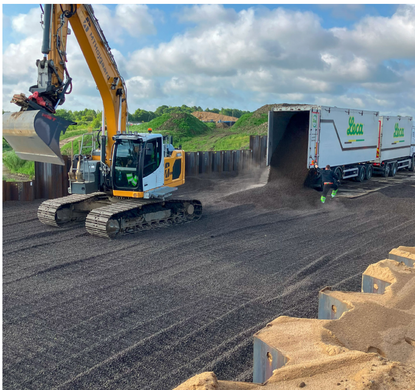
Colocación de áridos ligeros Leca® en la autopista E45, lo que reduce la carga y la presión del terreno en la estructura de la carretera.
