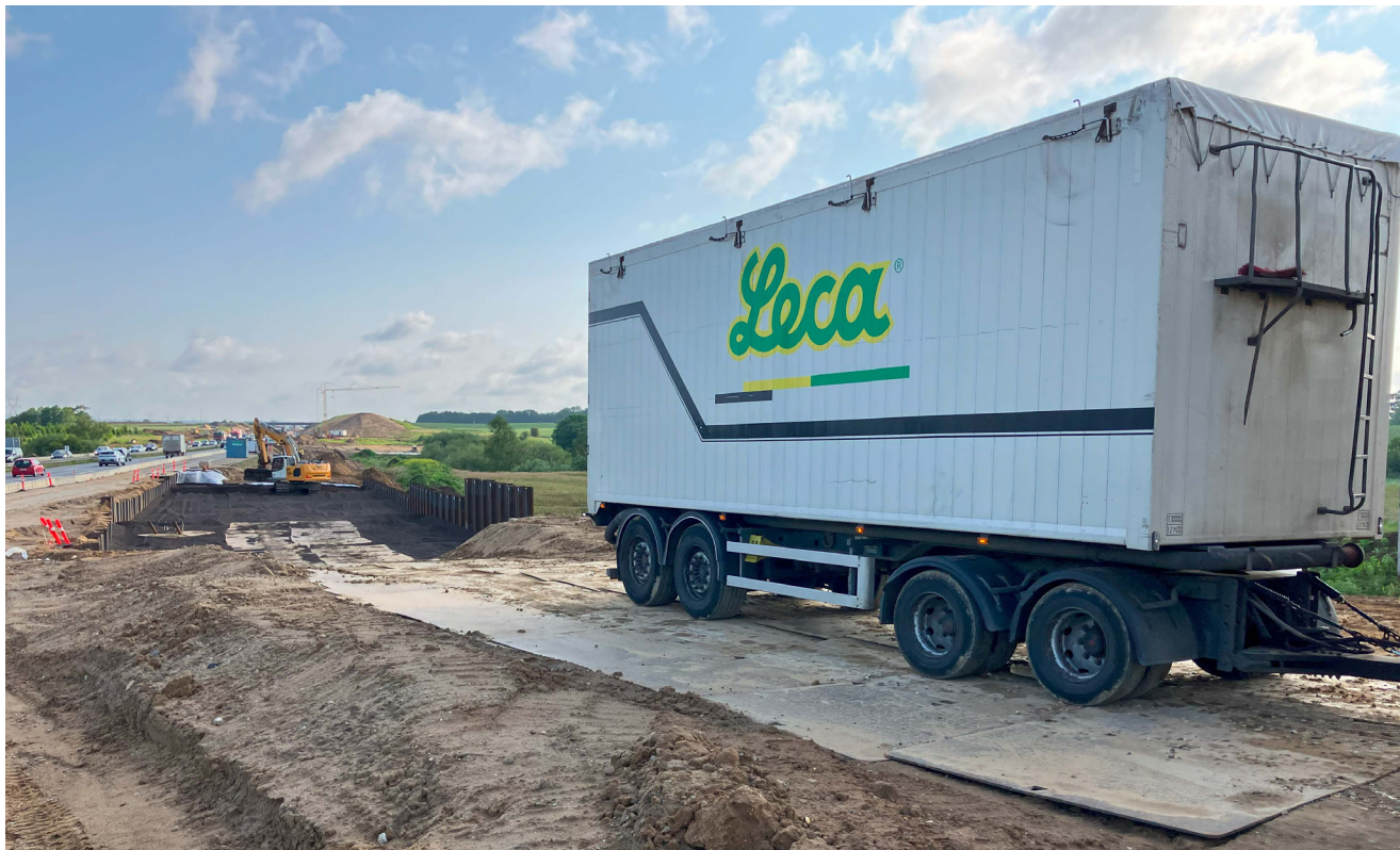
Entrega de árido ligero Leca® para la ampliación de la E45. El material llega listo para su colocación, lo que garantiza un proceso de construcción eficiente.
