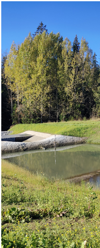
Dique de filtro integrado en una cadena de tratamiento más amplia.
