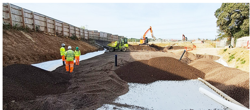
Más de 5600 m 3 de Leca LWA sostuvieron la ampliación de la alcantarilla antes de que comenzaran los movimientos de tierra.
