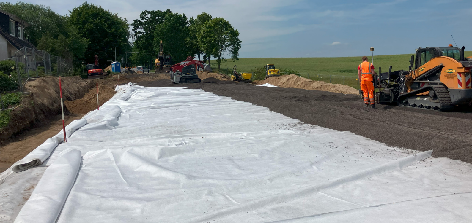
Leca LWA se encapsuló en un geotextil.
