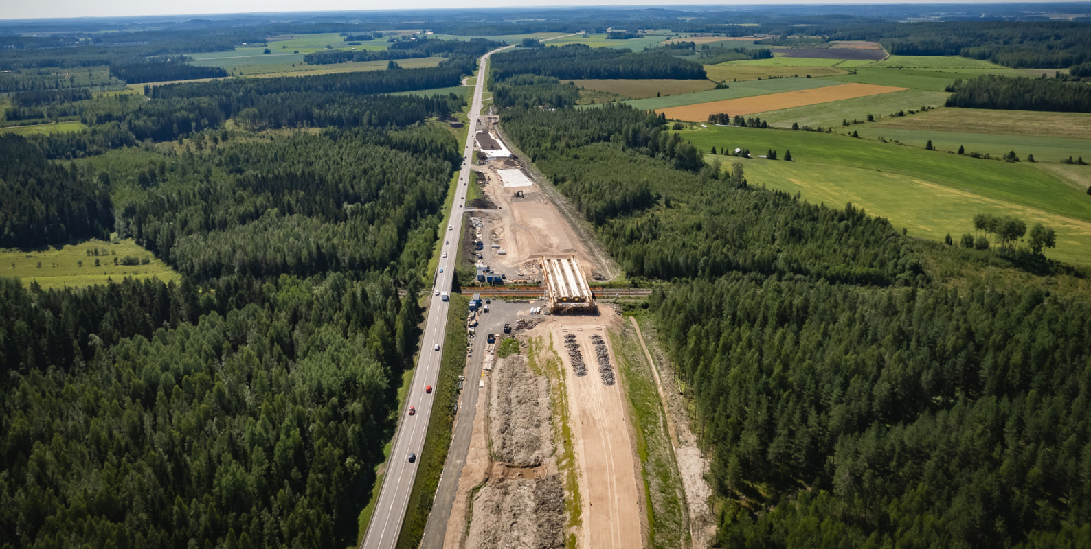
Vista aérea de la obra en Koria
