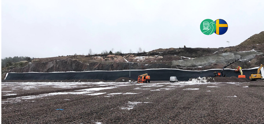
Sección completada de la estructura de contención a lo largo de la antigua cantera, lista para la siguiente fase.
