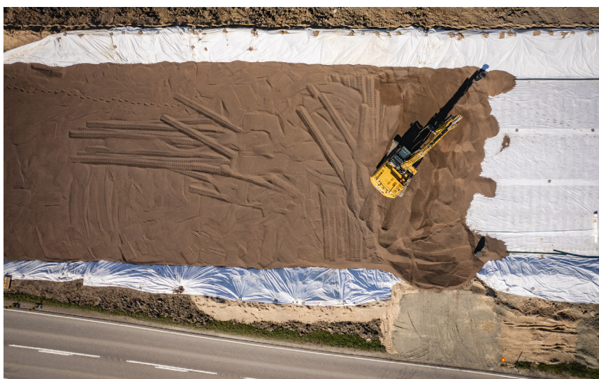
El Leca LWA se compactó con una excavadora sobre orugas.
