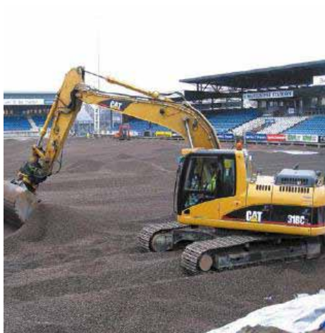
Figura 47. Uso de Arlita® en cimentación de campo deportivo.
