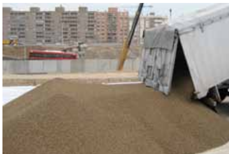
Figura 30. Suministro de Arlita ® en camión basculante.
