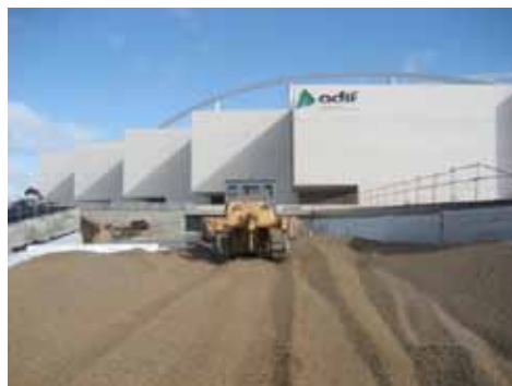
Figura 29. Colocado relleno aligerado de Arlita® con Dozer o excavadora.
