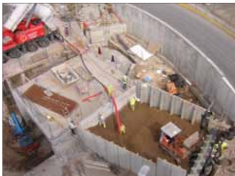
Figura 32. Puesta en obra mediante bombeo. Estacion de Lesseps- Barcel
