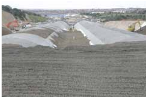
Figura 31. Relleno de Arlita ® sobre falso túnel M-50 Madrid.
