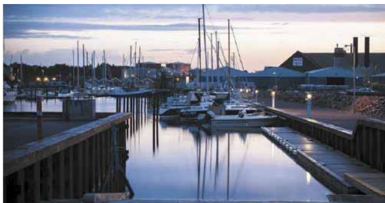
Figura 44. En Dinamarca la estabilidad de las estructuras de los puertos fue mejorada con el uso de Arlita®
