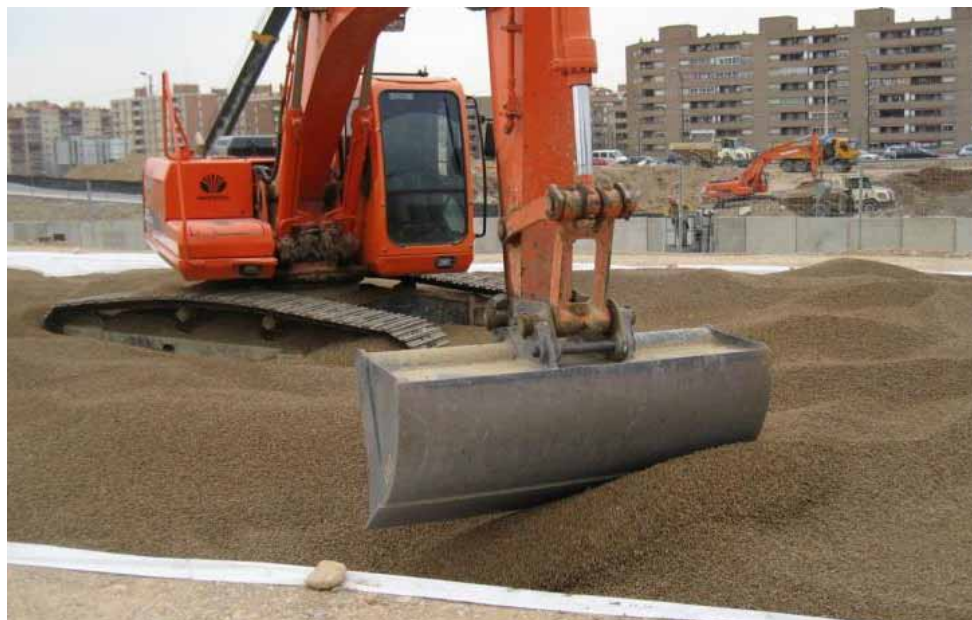
Figura 28. Extendido y compactación de Arlita® con excavadora en estación Ave Zaragoza.
