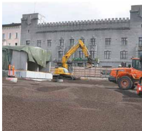
Figura 46. Uso de Arlita® en cimentación de plaza en Finlandia
