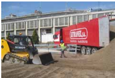
Figura 29. Suministro de Arlita ® en camión Walking-floor.
