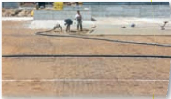
**ARLITA Leca L** es un árido sin capilaridad y aislante lo que permite resolver en una operación el drenaje y el aislamiento sobre el terreno, evitando la necesidad de construir un forjado sanitario, con el consiguiente ahorro en altura y en tiempo.
