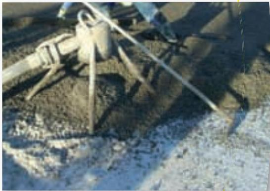
El uso del mortero ligero de **ARLITA Leca M** es la solución ideal para aquellas soleras y recrecidos en los que necesitamos evitar sobrecargas en la estructura. Su resistencia mecánica es muy superior a la de otros materiales tradicionales y su capacidad aislante, térmica y acústica proporciona mejores niveles de confort y en una sola operación.
